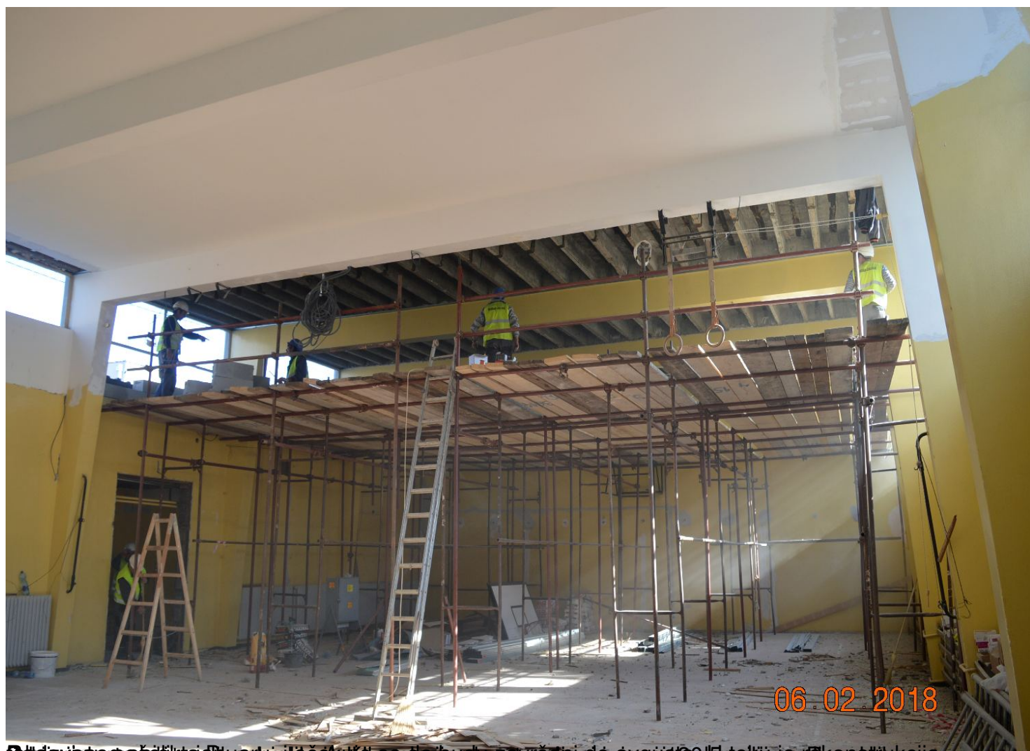
Rad na postavljanju i razbijanju krovne konstrukcije u prizemlju škole. Radnici su postavili i razbili krovne konstrukcije u prizemlju škole. Radnici su postavili i razbili krovne konstrukcije u prizemlju škole.
