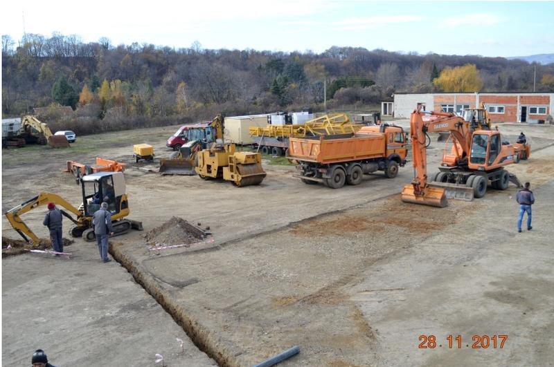
Zaposleni Građevinske operative, transporta i mehanizacije započeli su pripremu terena za asfaltiranje pogona Pemci. Osim zemljanih radova na površinama gde će biti naneta asfaltna podloga, istovremeno se radi i na postavljanju hidrantske mreže.
