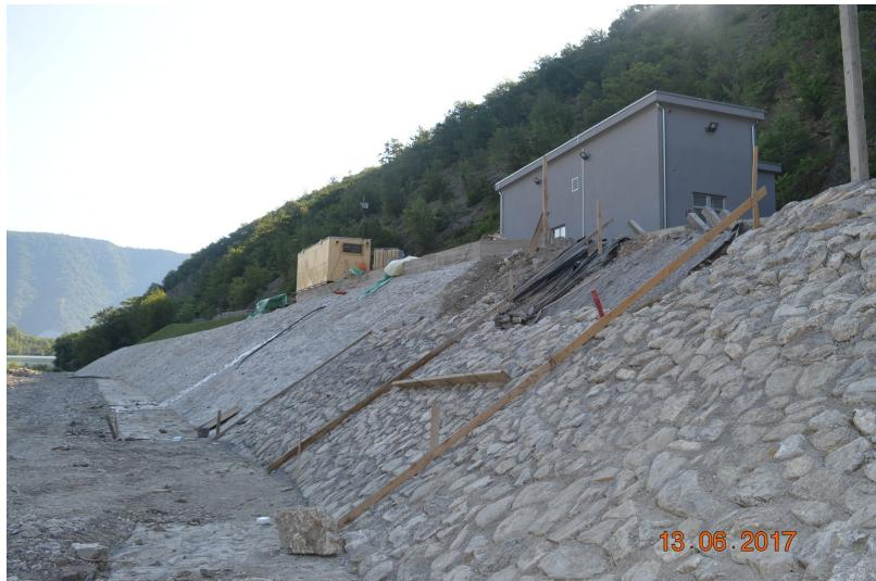
Privode se kraju radovi na jednom od najvećih gradilišta na području opštine Kladovo. Zaposleni Građevinske operative i Transporta i mehanizacije ĐERDAP USLUGE a.d. Kladovo završavaju uređenje obalotvrde rečice Kosovica kao i rekonstrukciju crpne stanice.
